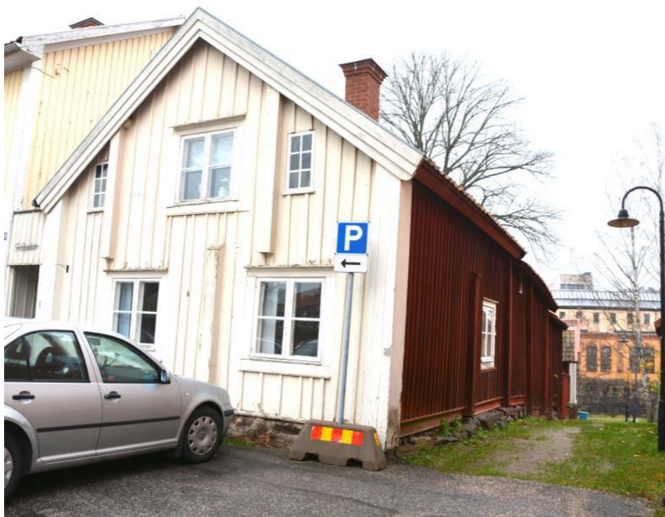
Bild på 1700-tals huset från antikvariska förundersökningen.
